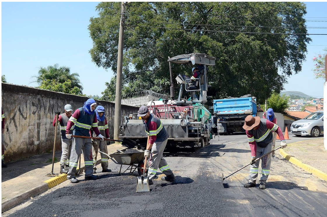
Imagem 6 e 7 – Exemplos de uso de agregados reciclados em obras
